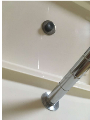
穴を開けボルトとワッシャーで固定の様子
